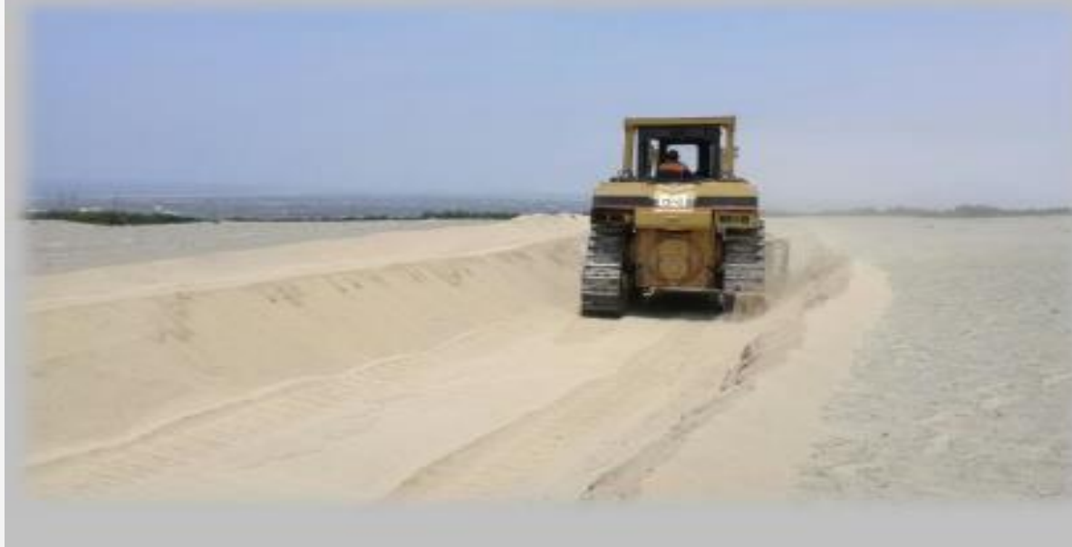
1ra Semana: Trazado y demarcado de terrazas, altimetría por niveles para configuración de terrazas.
