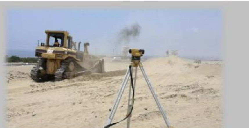
Generación de accesos hacia el área reservada para el ovalo.
