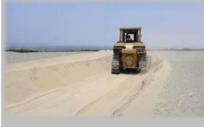
1ra Semana: Trazado y demarcado de terrazas, altimetría por niveles para configuración de terrazas.
