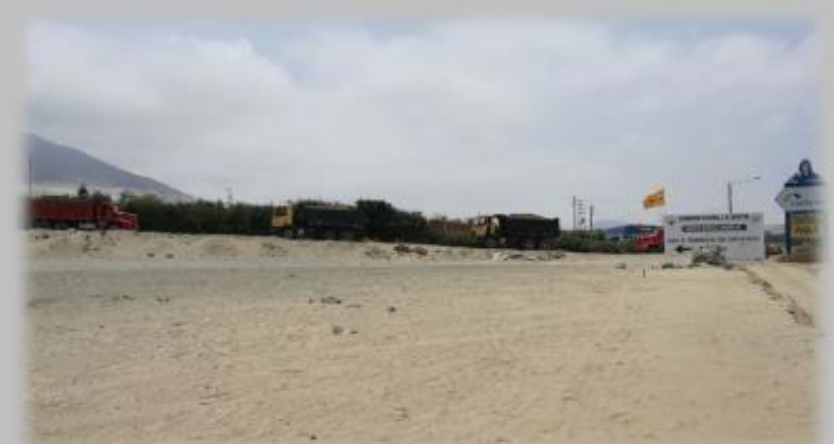
Acopio y deposito de material para estabilizar accesos a terreno para ingreso de maquinaria al área reservada para el ovalo
