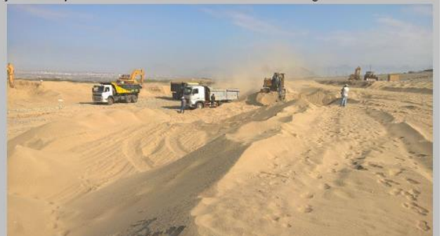
6ta Semana: Corte y Relleno para conformación de terrazas hacia el ingreso
