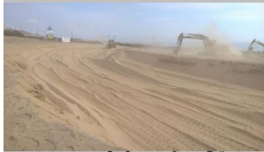
5ta Semana: Corte y Relleno para conformación de terrazas hacia el ingreso
