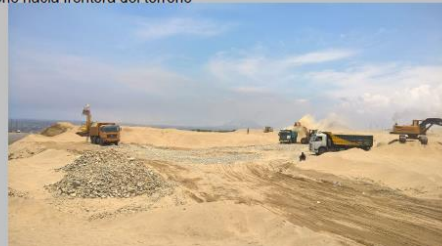
3ra Semana: Corte y Relleno hacia frontera del terreno
