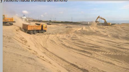
4ta Semana: Corte y Relleno hacia frontera del terreno
